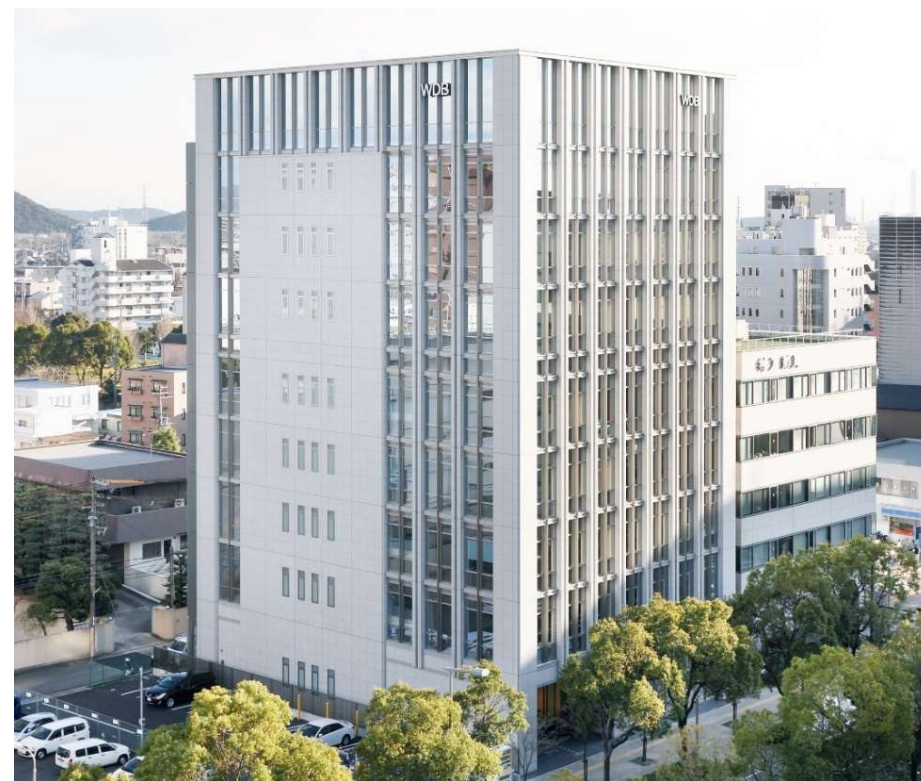
WDBHD 本社ビル（兵庫県姫路市）
