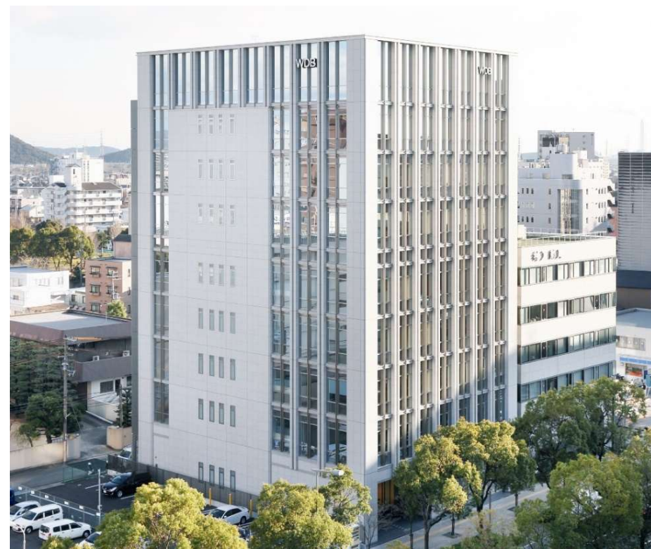
WDBHD 本社ビル（兵庫県姫路市）
