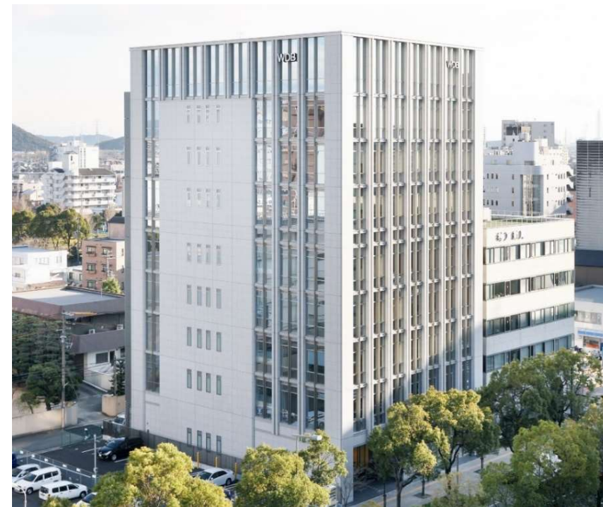
WDBHD 本社ビル(兵庫県姫路市)
