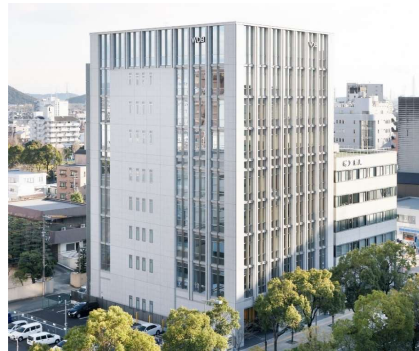
WDBHD 本社ビル(兵庫県姫路市)
