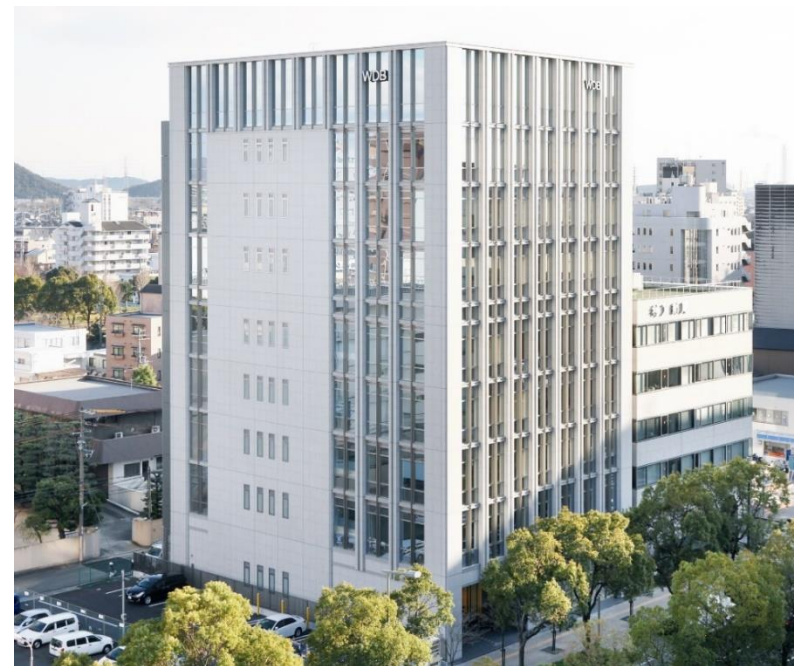
WDBHHD 本社ビル(兵庫県姫路市)
